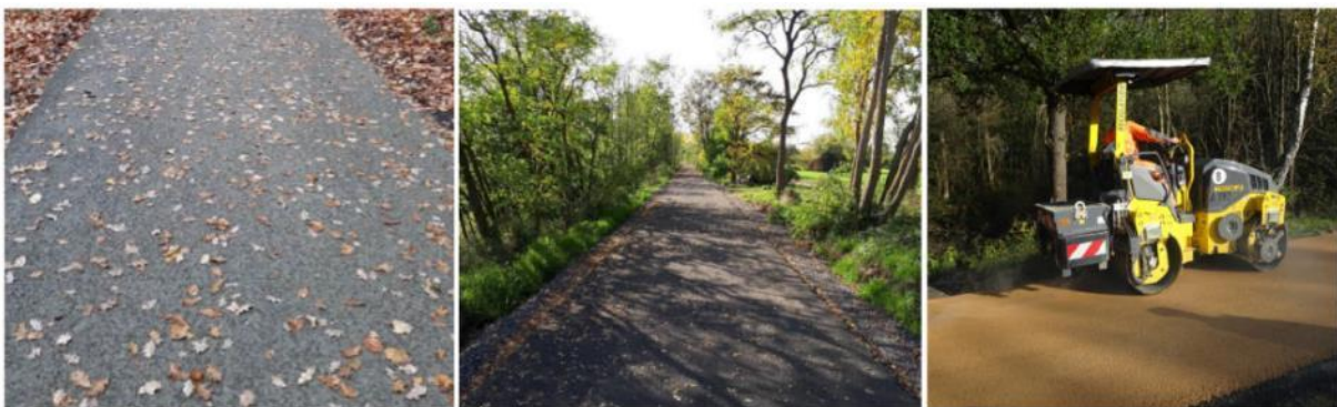
Abbildung 7: Asphaltähnliche Deckschichten aus Gemisch von Basaltstein und Speziaisanden (links, Mitte), heller Split-Mastix-Asphalt (rechts) (Quelle: Eigene Darstellung).
