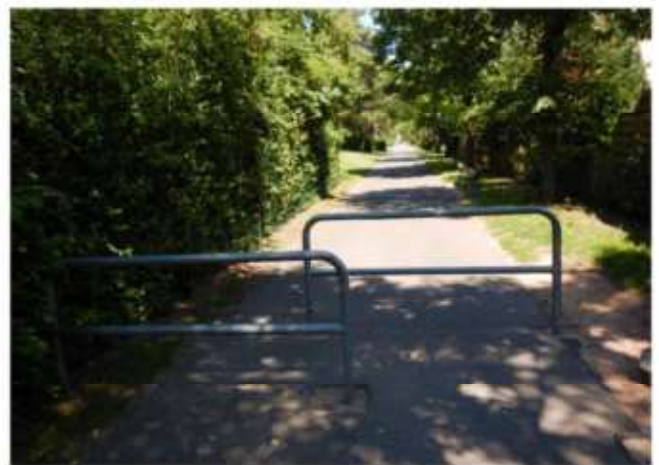
Abbildung 1: Umlaufsperrren mit zu geringer Durchgangsbreite, Überlappung der Gitter und ohne (reflektierende) Markierung
