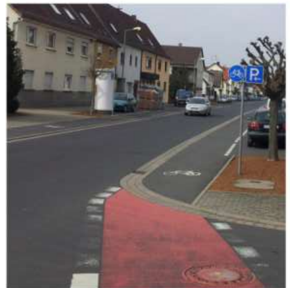
Abbildung 1: Bordsteinabsenkung Fahrbahn - Radweg, Frankfurt am Main
