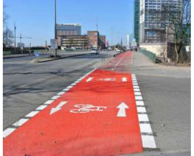
Rot eingefärbter Zweirichtungsradweg
