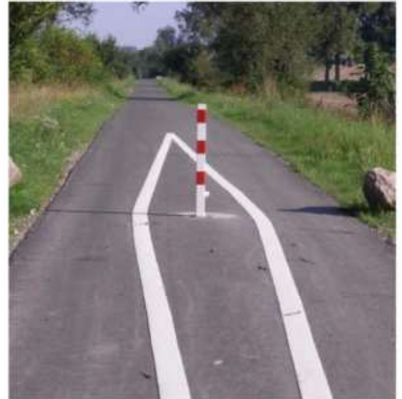
Abbildung 1: Warnmarkierung eines Sperrpfostens
